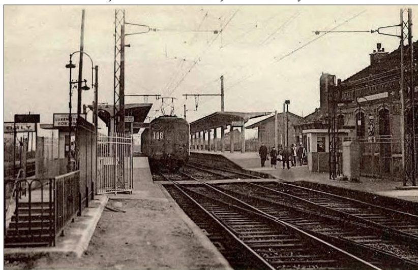
Massy-Verrières, la gare du Métro après l'électrification.
